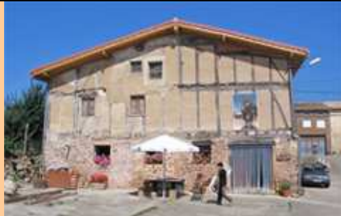
Fachada del Refugio
